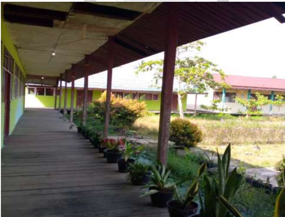
Photo Dokumentasi Bangunan Sekolah/Lokal SMPN 02 Gaung Anak Serka.
