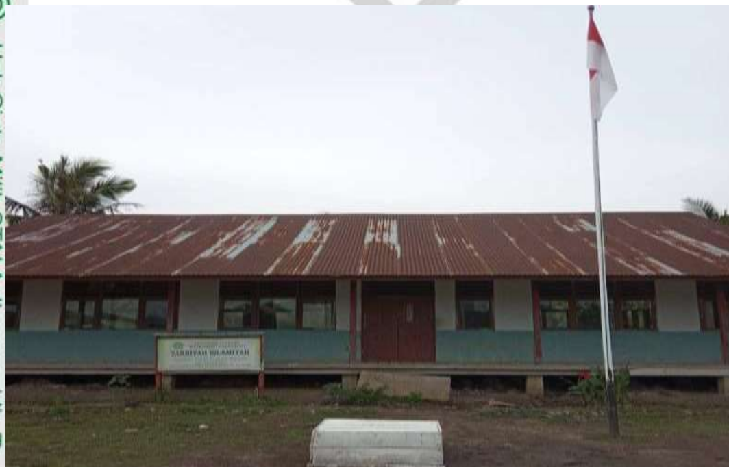
GEDUNG MADRASAH TSANAWIYAH TARBIYAH ISLAMIYAH SUNGAI SIMBAR KECAMATAN KATEMAN
