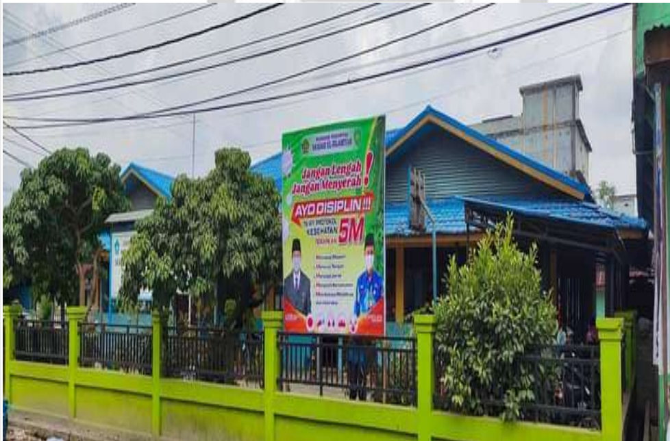
GEDUNG MADRASAH EL ISLAMIYAH TEMBILAHAN
