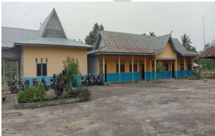
GEDUNG MADRASAH TSANAWIYAH NURUTTHALIBIN TELUK JIRA KECAMATAN TEMPULING
