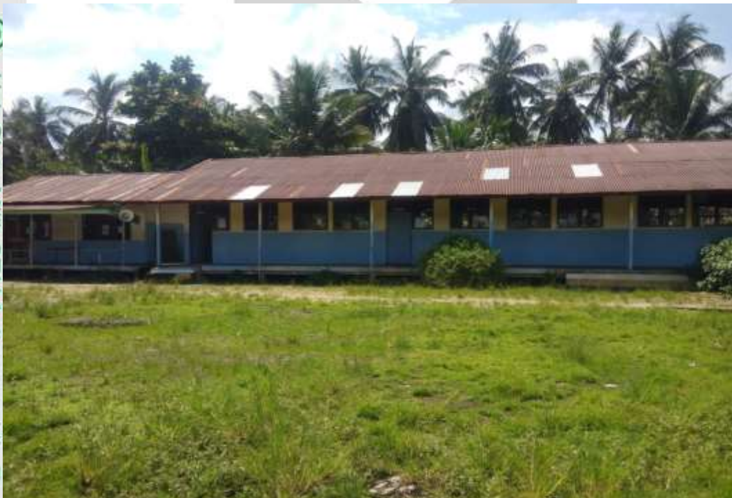
GEDUNG MADRASAH TSANAWIYAH NURUL IMAN DESA SUNGAI LOKAN KECAMATAN ENOK
