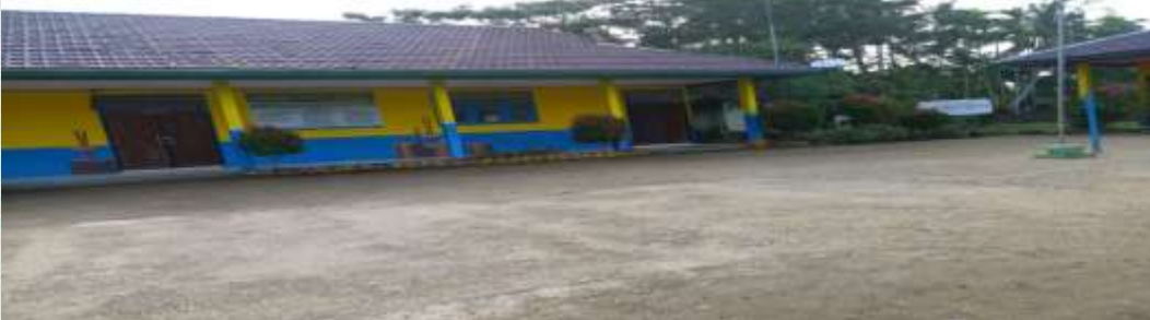
GEDUNG MADRASAH TSANAWIYAH NAHDHATUS SHIBYAN TELUK KIAMBANG KECAMATAN TEMPULIN
