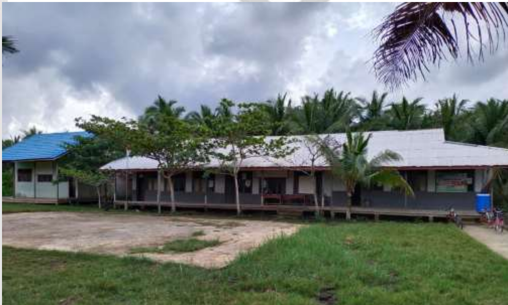
GEDUNG SEKOLAH DASAR NEGERI 009 KAMPUNG BARU KECAMATAN CONCONG
