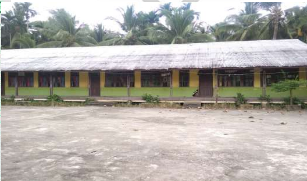
GEDUNG SEKOLAH DASAR NEGERI 009 KUALA LEMANG KECAMATAN KERITANG
