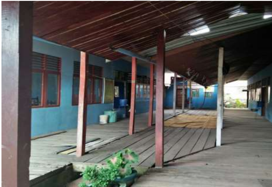
GEDUNG MADRASAH TSANAWIYAH NURUL JIHAD KECAMATAN TEMBILAHAN HULU
